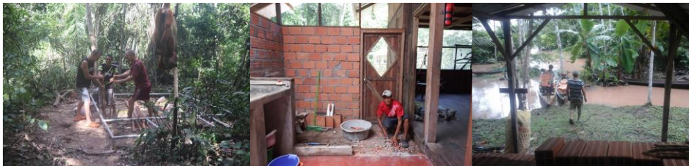
Constructie in de jungle is een grote uitdaging
