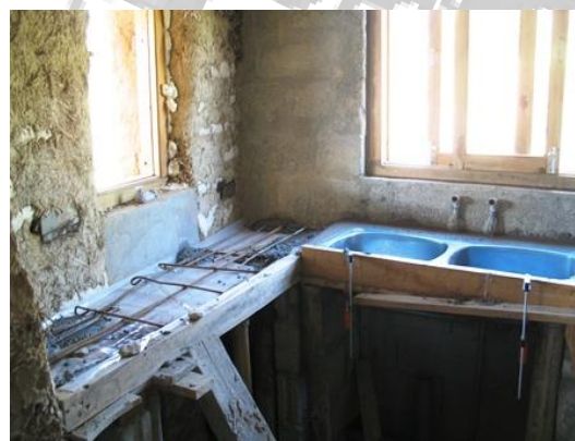
Keukenblokje in aanbouw.
