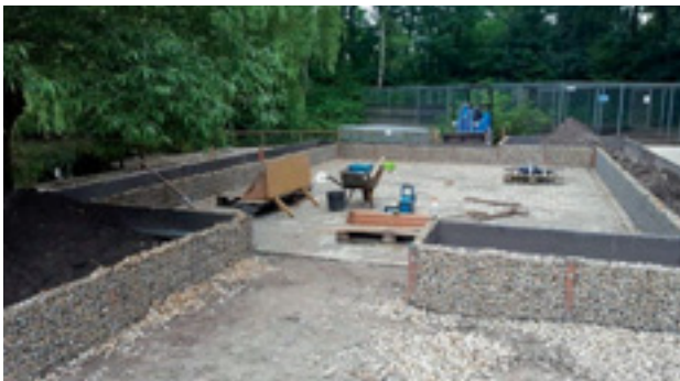
Aanleg nieuwe terras
